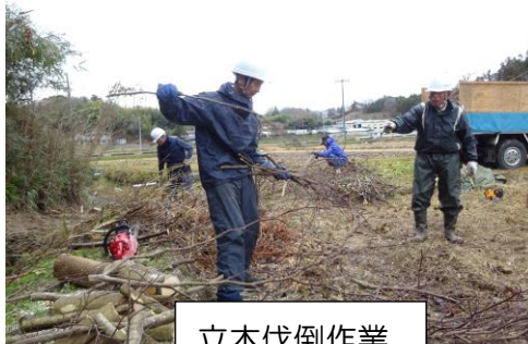
立木伐倒作業
