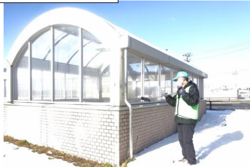
地下道清掃作業
