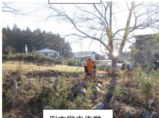
倒木撤去作業
