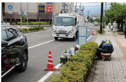
中道町線 除草作業
