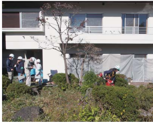
1階の窓ガラス前面に飛石防止シートを設置
