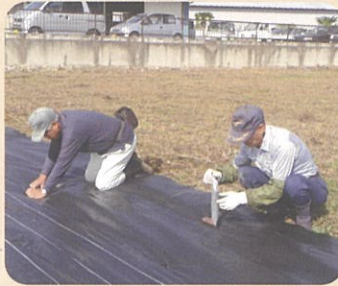
防草シート張り
