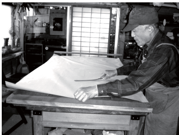
障子の張替えの様子
