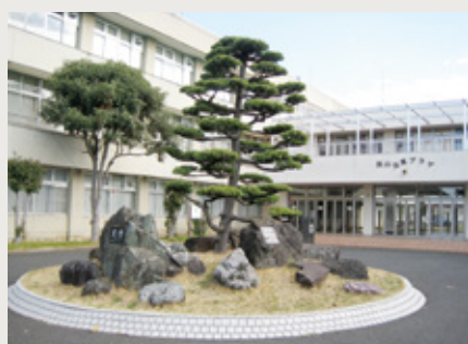
2012年 シルバー人材センター移転 (2022年現在の元気プラザ内)
