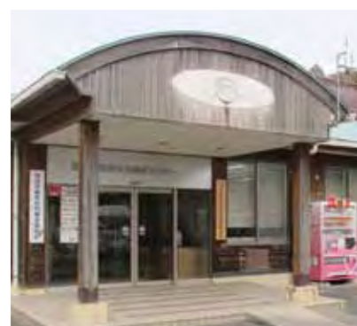
島根県シルバー人材センター連合会の隠岐分室(隠岐の島町社会福祉センター内)
