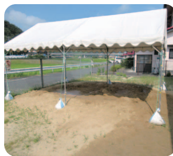
砂場・テントを整備
