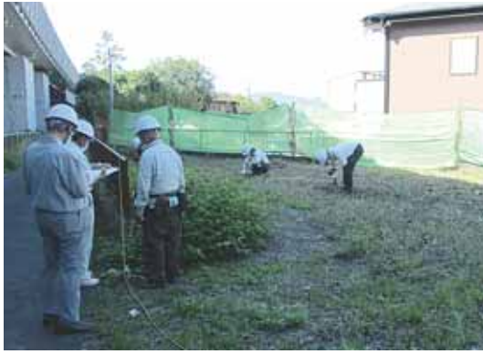
安全パトロールの様子
