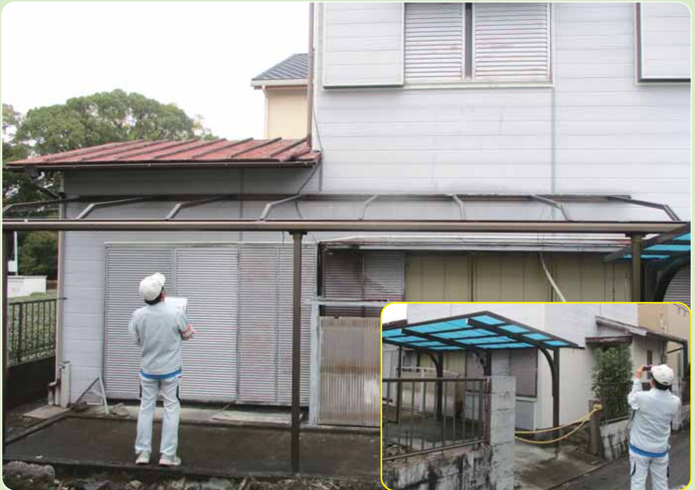
目視による建物外観の確認作業中
