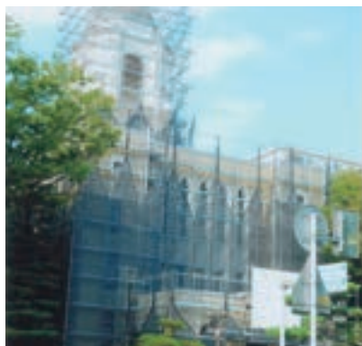
静岡市役所本館昭和9年完成 現在点検、補修中
