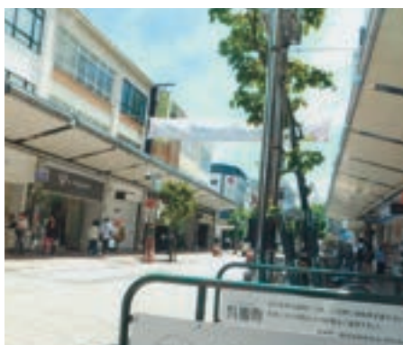
呉服町通商店街（防火帯） 両側全体が共同防火建築商店
