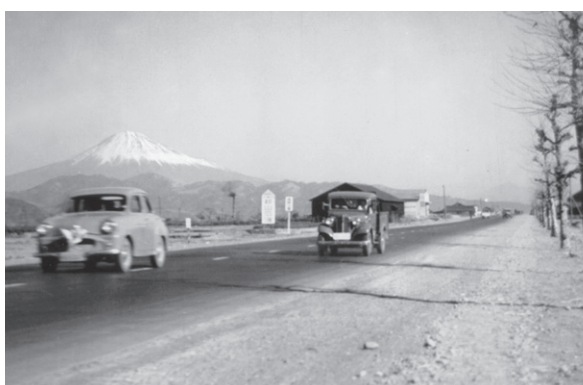
昭和3年起工の静岡国道1号線 長沼、古庄付近（昭和31年）
