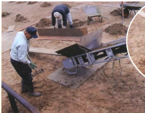
上水道の砂かき搬出
