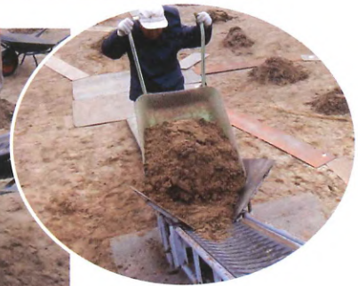
上水道の砂かき搬出
