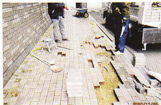
インターロッキング修繕作業
