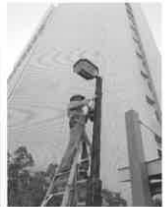
外灯の塗装作業
