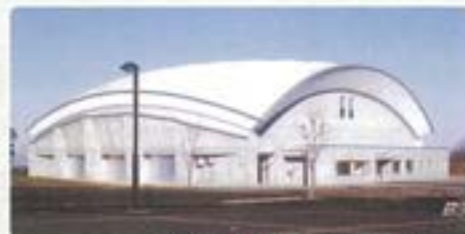
シルバー人材センター事務所▲ (たてやまドーム)
