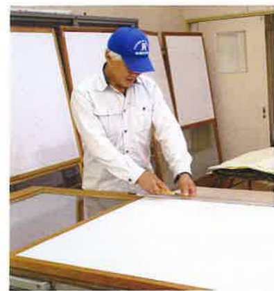
障子の張替え作業
