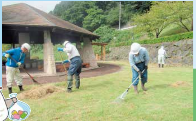
立沢ダム・片付け
