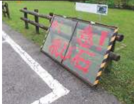
網戸改良飛び石防護ネット
