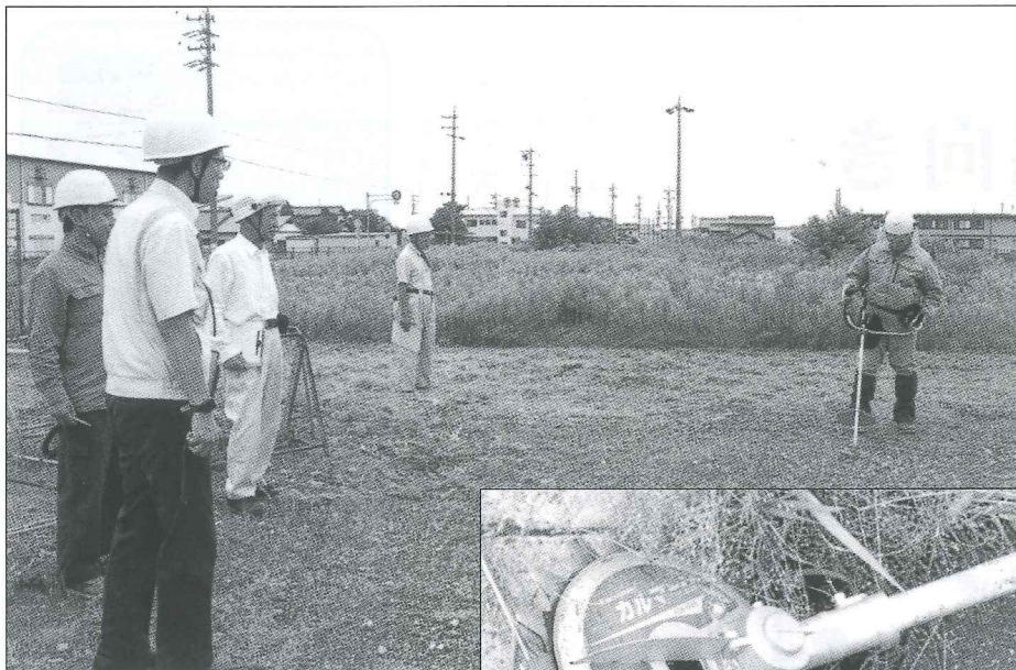
カルマー式の草刈機で作業を行う様子を安全委員がパトロール 写真下は、カルマー（石が飛びにくい草刈機）
