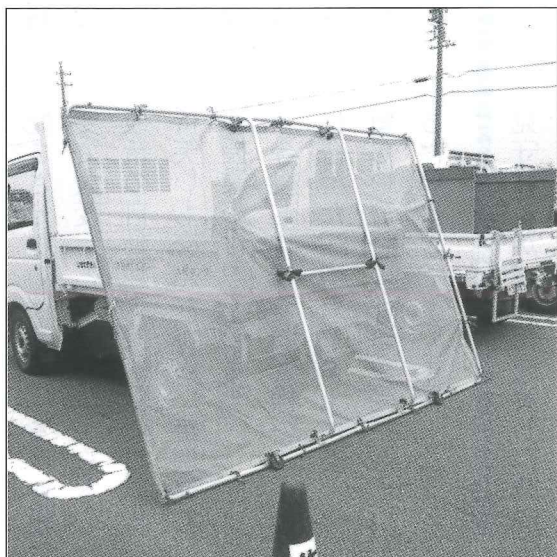
◀道路沿は作業員が移動式防護ネットで
