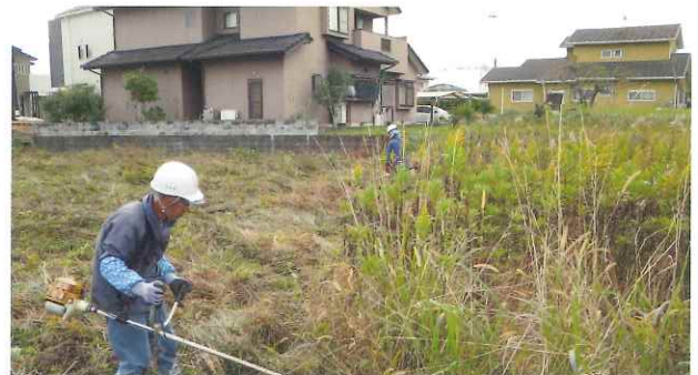
間隔を空けて作業しています!!
