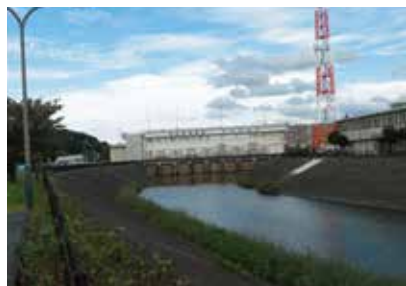
大和田排水機場
