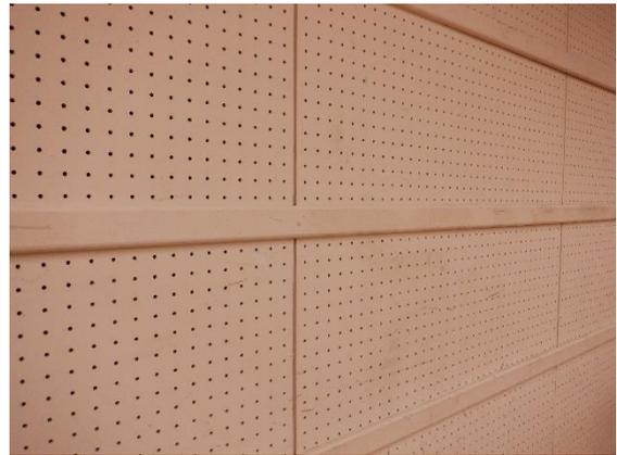
写真4：解体撤去する押縁材
