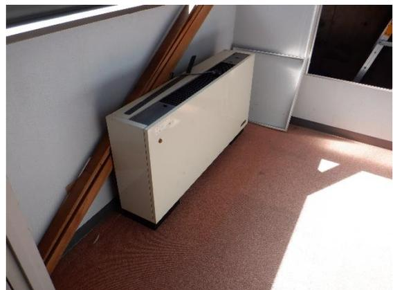
写真2：解体撤去する空調装置
