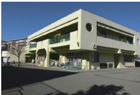
横浜市飯島保育園 飯島小学校が隣接している
